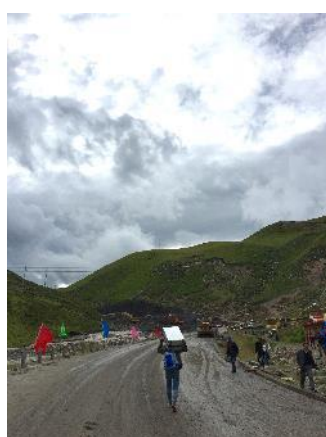
土砂崩れによる交通制限
